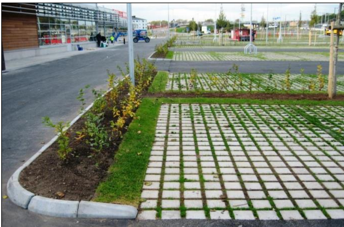
Figur 9. Parkeringsyta med genomsläpplig beläggning. (Foto: Norconsult)
