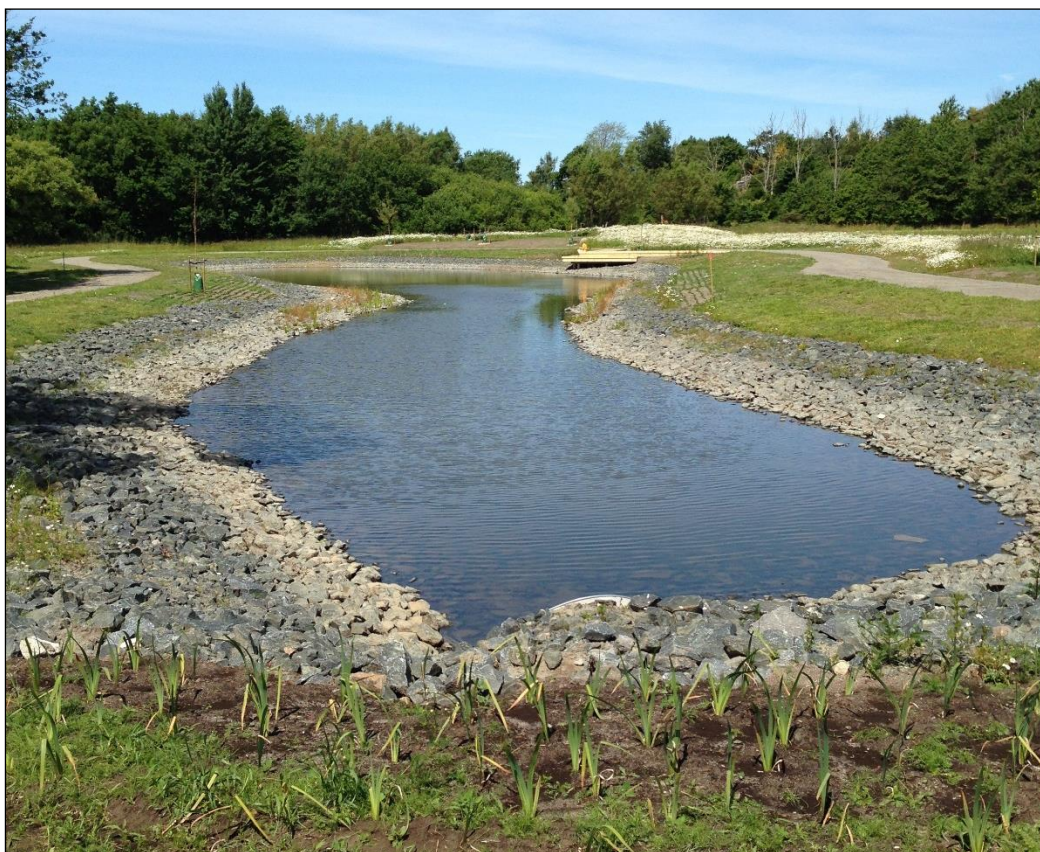
Figur 10. Exempel på dagvattendamm i Trönninge i Varberg. (Foto: Norconsult)
