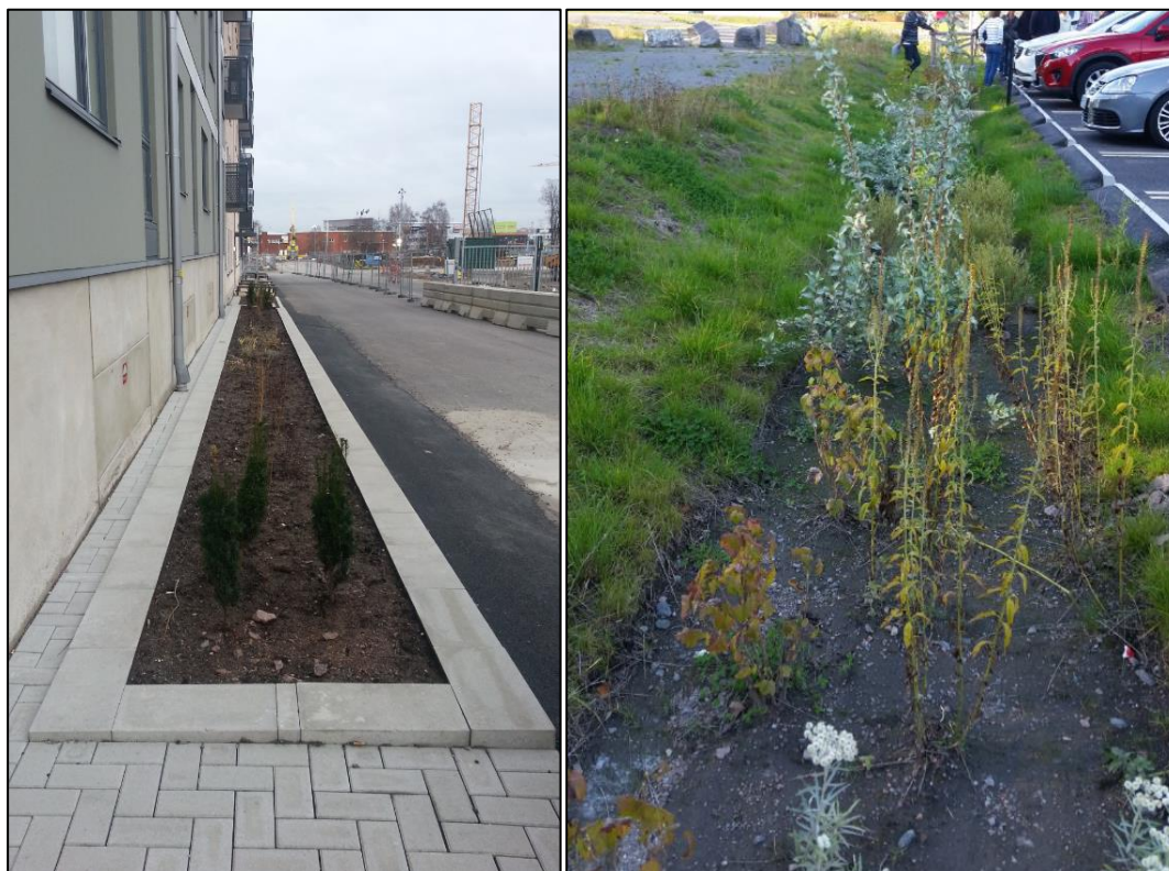
Figur 11. Illustration av en nyanlagd regnrabatt intill byggnad och i kombination med dike. (Foton: Norconsult)
