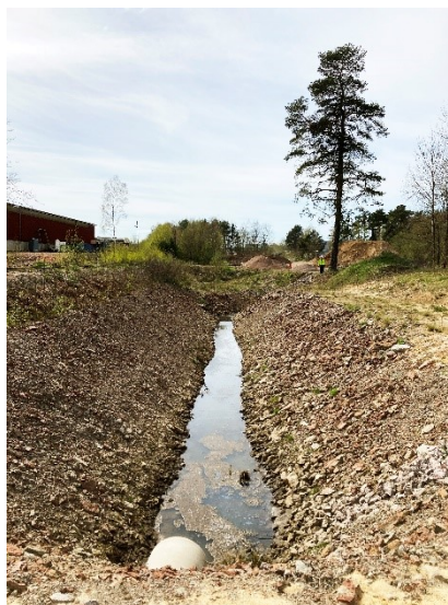
Befintligt dagvattendike i nordost.
