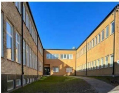
Södra sidan. Förbindelse mellan hus D och E.
