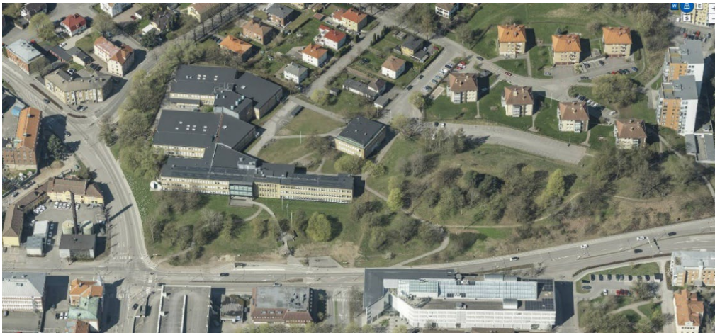
Ortofoto på Västerhöjdsgymnasiet sett mot väster.
