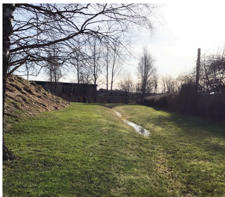
Dike längs fastighet Frösve 2:70 och 2:71.
