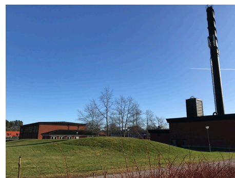
Där gräskullen finns idag kan en infart med parkering anordnas. På bilden syns Skövde Energi:s panncentral med skorsten. Till vänster syns Stöpenskolans idrottshall.
