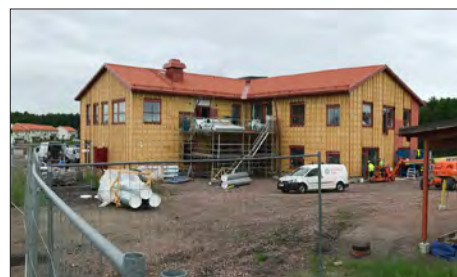
Ny förskola med namnet Mellomkvarns förskola under uppförande i etapp 2.
