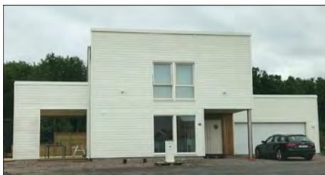
Hus med platta tak är också välkomna i Trädgårdsstaden. Nybyggt hus i etapp 2.
