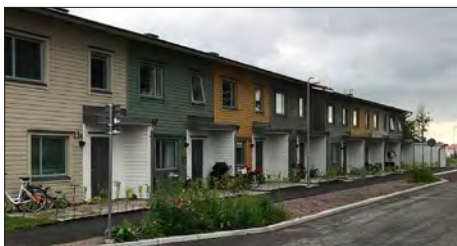
Markerade välkomnande entréer. Nybyggda radhus i etapp 2.
