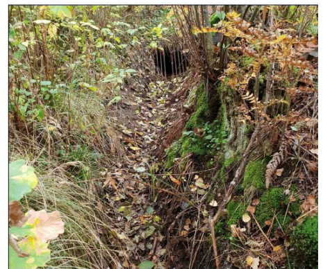
Dike och dagvattenledning 300 mm BTG med galler som avleder dagvatten från lågpunktsområdet i nordöst. Norconsult 2019-04-05
