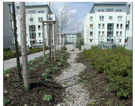
Exempelbild på fyllt dike, Norconsult
