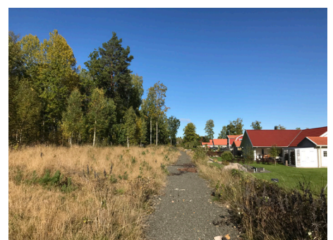
Befintligt djupdräneringsdike mot befintlig bebyggelse vid Björkebacken etapp I.
