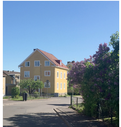
Ett foto från grannkvarteret som visar ett flerbostadshus med två våningar och vind, av en typ som är vanligt förekommande på Norrmalm. Sockel av kalksten, spritputsade, gula fasader och rött tegeltak och omgivet av fruktträd.
