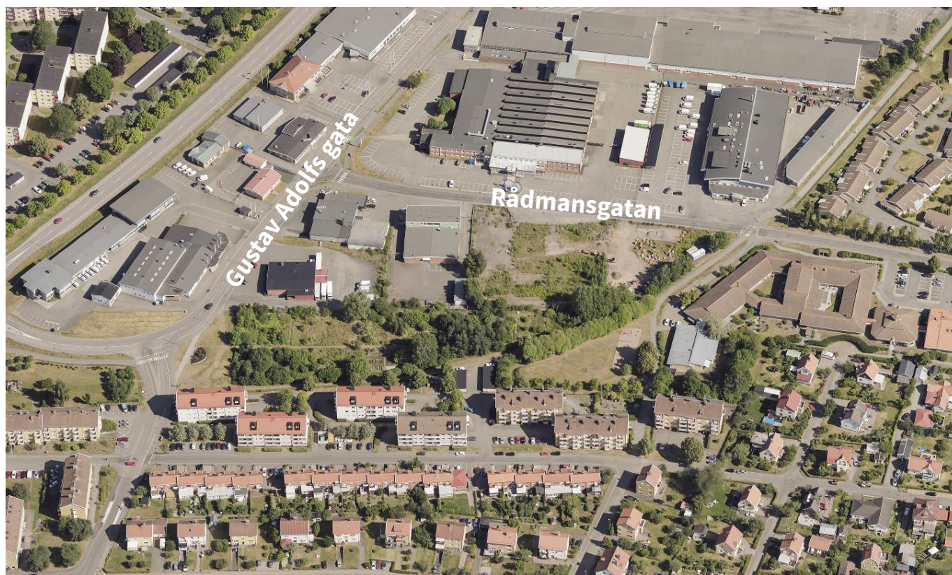
Snedbild över planområdet, befintlig bebyggelse i och i anslutning till planområdet
