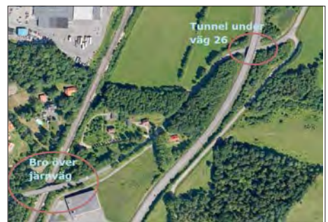
En förlängd gång- och cykelväg längs Gamla Törebodavägen mot Kvarnsjön tar utrymme från vägbanan under väg 26 och bron över järnvägen och skapar flaskhalsar. Trafikutredning visar på effekterna av detta och vad som händer om dessa byggs bort.
