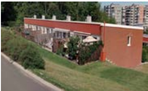
Bild på baksidan av ett av radhusen
