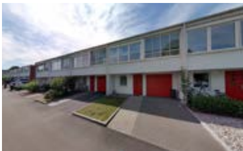
Bilder på framsidan av radhusen
